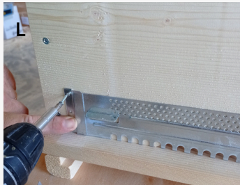
L. Avvitare le guide(12) per la porta con le viti del 20
