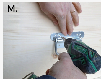
M. Montare le maniglie (17) con le viti da 2.5.
