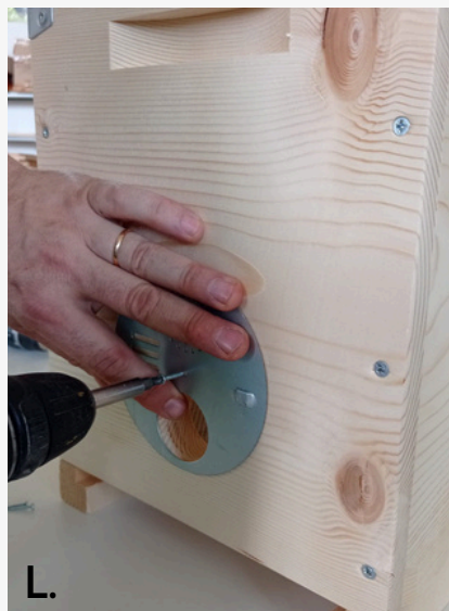
IL. Montare i dischi 4 posizione con viti da 20.
